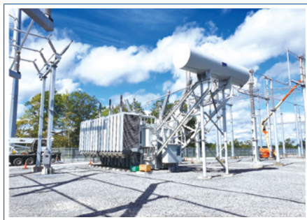
▲ 500kV 350MVA(First Energy_미국)
